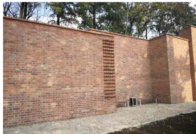
Mury obronne przy ul. Piastowskiej w Namysłowie
