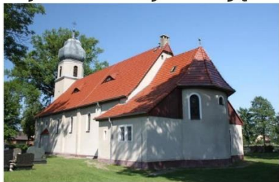
Kościół pw. Wniebowstąpienia Pana Jezusa w Miejsu
