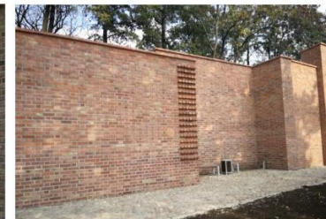
Mury obronne przy ul. Piastowskiej w Namysłowie
