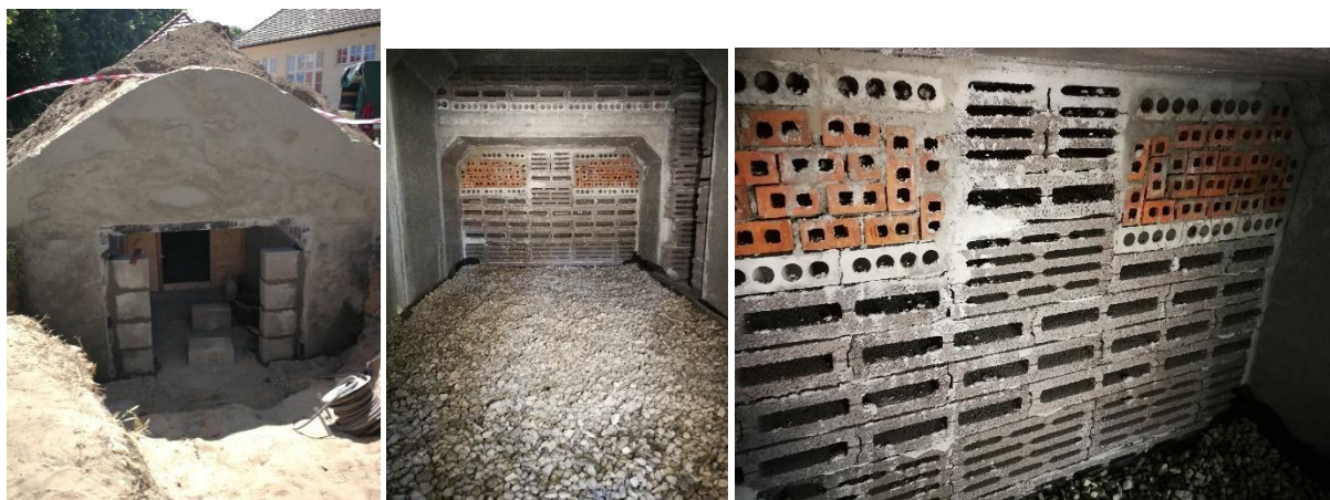
Piwniczka dla nietoperzy – widok z wewnątrz i zewnątrz
