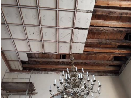
Zdj. wykonane w trakcie remontu (autor: ks. K. Odzimek)
