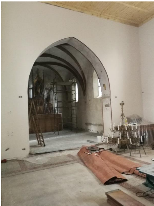
Zdj. wykonane w trakcie remontu (autor: ks. K. Odzimek)
