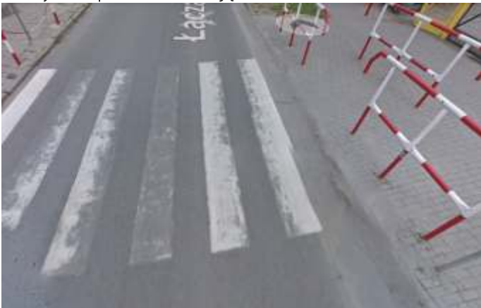
Przejście dla pieszych znajdujące się przy Szkole Podstawowej nr 3 w Namysłowie przed modernizacją:
