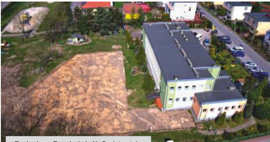
Rozbudowa Przedszkola Nr 5 z lotu ptaka
